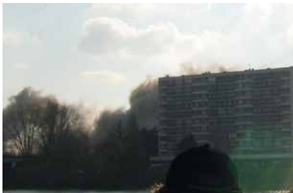
Le Tripode fut démoli par dynamitage dans la matinée du 27 février 2005 devant 30 000 personnes - Photos © Wikileft Jmtrivial -
